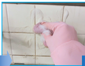
②スポンジ等で塗布
